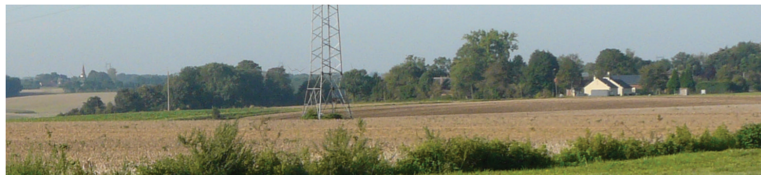
Zoom sur les éoliennes du projet
