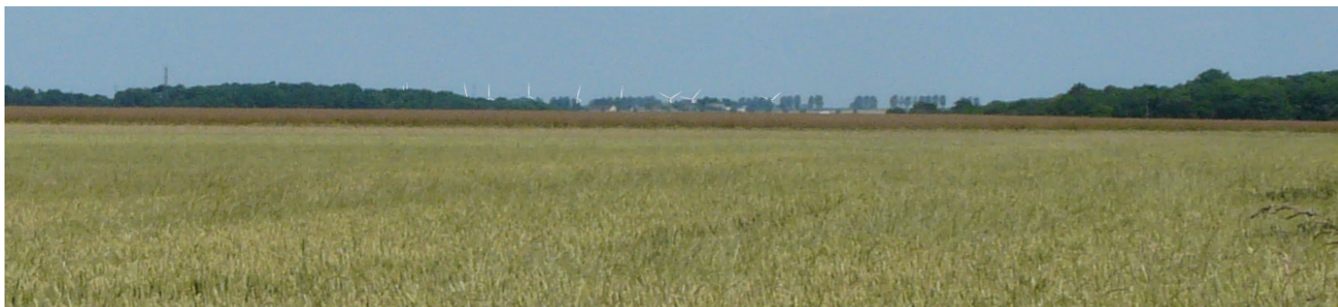
Zoom sur les éoliennes du projet
